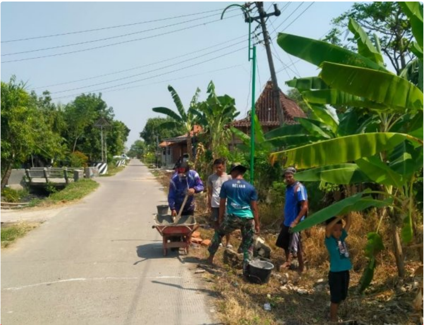
Satgas TMMD Reguler Ke-117 Kodim 0717/Grobogan Perbaiki Tiang Lampu Penerangan Jalan Di Desa Cangkring
